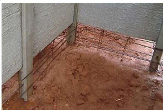
Figura 65 – Armado de la viga de cimentación.
