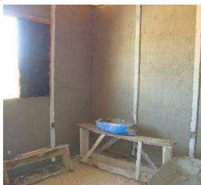
Figura 78 – Revoque grueso y revoque fino en la cara interna de las placas de cerramiento.
