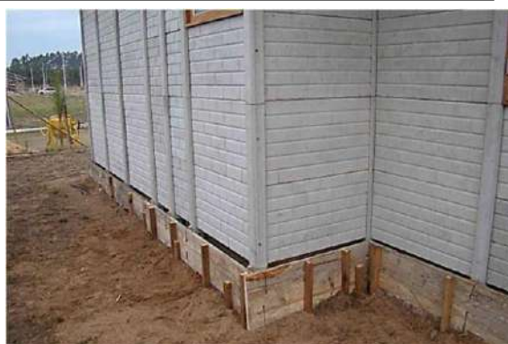
Figura 66 – Moldes en madera para hormigonado de la viga de cimentación.
