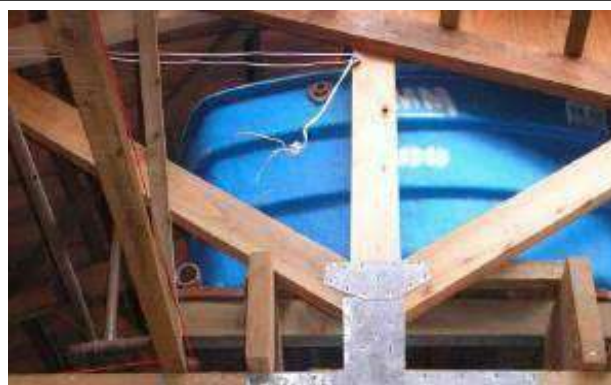
Figura 63 – Tanque de agua instalado sobre estructura de madera.
