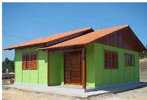
Figura 81 – Terminación externa de las placas de cerramiento en pintura acrílica.
