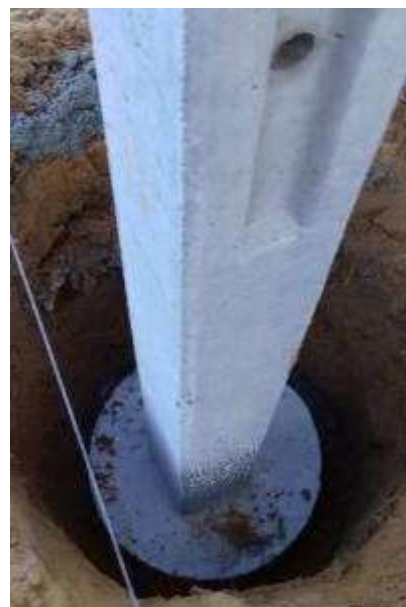
Figura 46 – Pilar apoyado sobre pieza circular prefabricada de hormigón.
