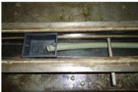
Figura 33 – Posicionamiento del conducto eléctrico y caja de paso en el encofrado metálico.
