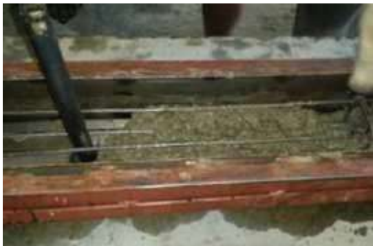
Figura 42 – Colocación de la primera capa de hormigón en el encofrado metálico.
