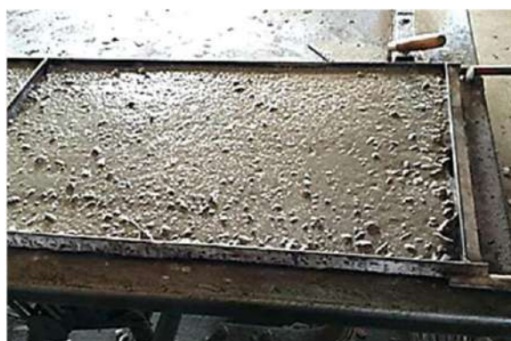
Figura 17 – Encofrado con la primera capa de hormigón.
