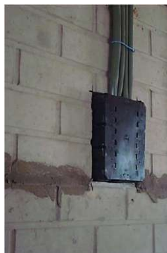
Figura 75 – Caja de instalaciones eléctricas fijadas a la placa de cerramiento.
