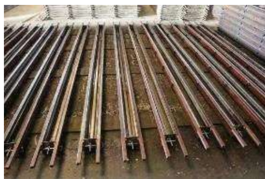
Figura 39 – Encofrados limpios, armados y con desmoldante aplicado.
