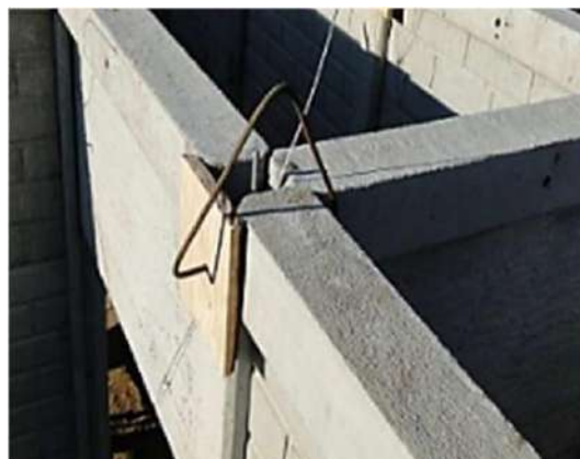
Figura 8 – Detalle – Vano entre pilar y vigas posteriormente concretado.
