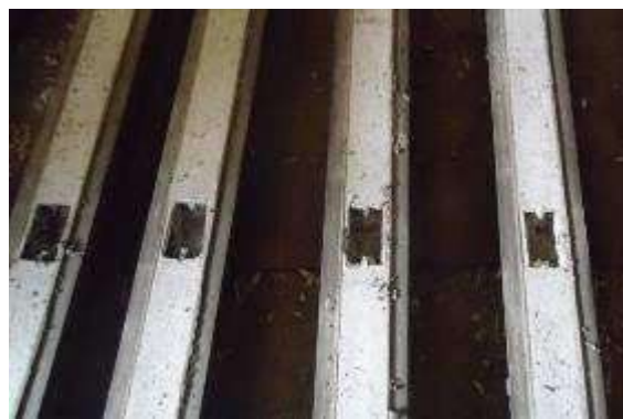
Figura 34 – Pilar hormigonado con caja de paso para la instalación eléctrica.
