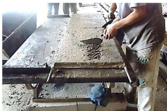
Figura 19 – Placa de cerramiento luego de la vibración de la segunda capa de hormigón.
