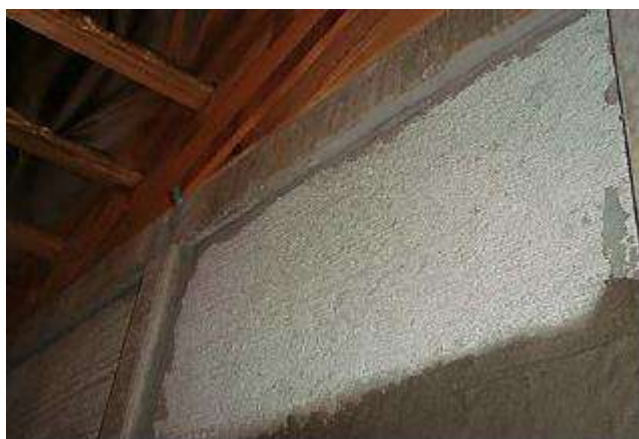
Figura 71 – Vano entre placa de cerramiento y viga de hormigón relleno con argamasa AC III.
