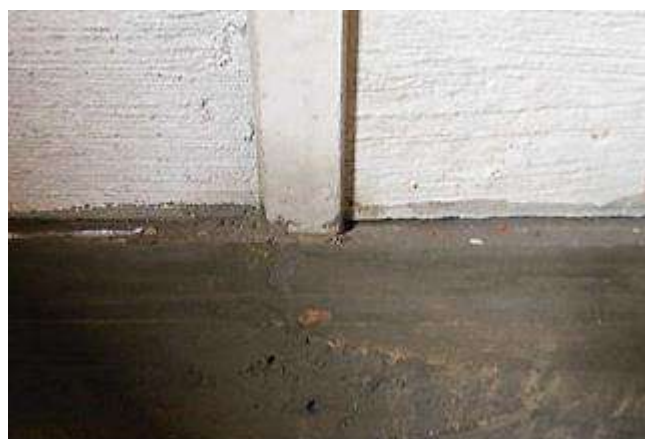
Figura 72 – Vano entre placa de cerramiento y viga de cimentación relleno con argamasa AC III.
