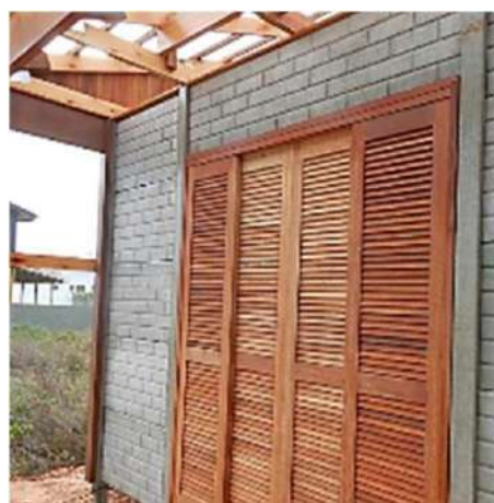
Figura 52 – Puerta instalada entre pilares prefabricados
