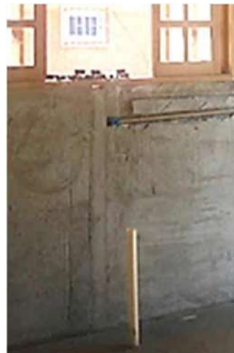
Figura 77 – Cañería hidráulica de la pía de la cocina embutida en argamasa de revestimiento.
