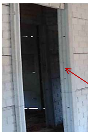
Figura 51 – Orificios en el pilar prefabricado para fijación del marco de la puerta.
