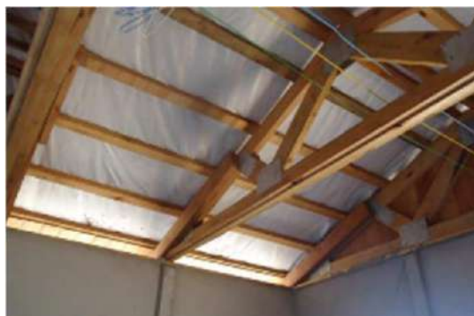
Figura 60 – Sistema de cobertura con estructura en madera y manta aluminizada.
