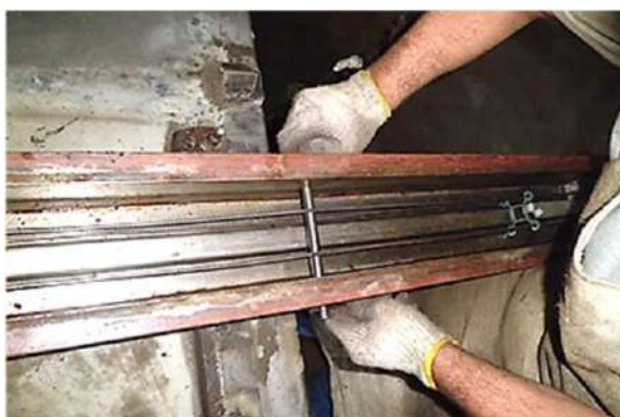
Figura 23 – Encofrado metálico para pilares prefabricados en hormigón armado.
