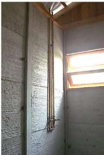
Figura 76 – Cañería hidráulica del box, fijada por fuera de la placa de cerramiento.
