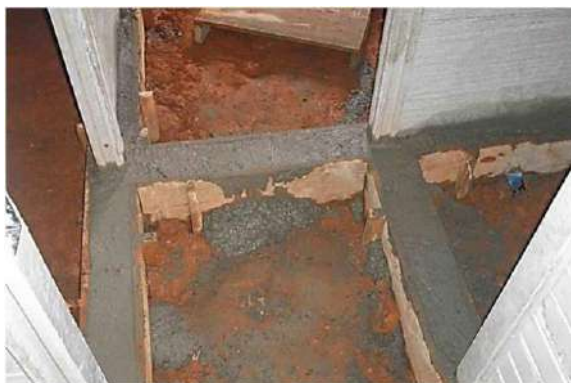
Figura 67 – Hormigonado de las vigas de cimentación.
