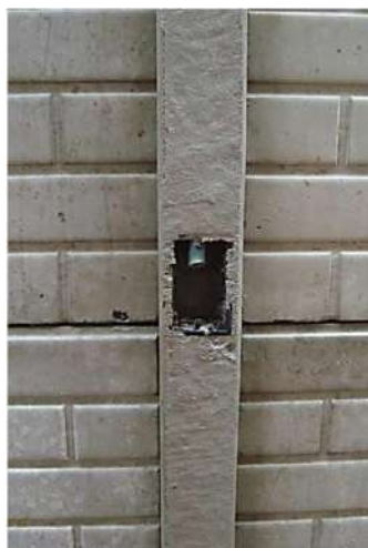
Figura 74 – Electroducto y caja de luz embutida en el pilar prefabricado.
