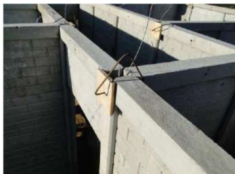
Figura 58 – Preparación para el hormigonado del vano entre vigas sobre pilar.
