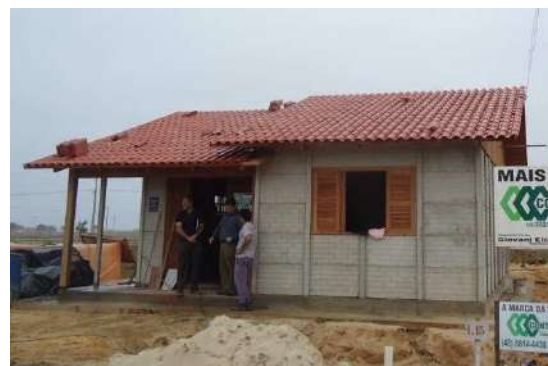
Figura 61 – Sistema de cobertura con tejas de cerámica.
