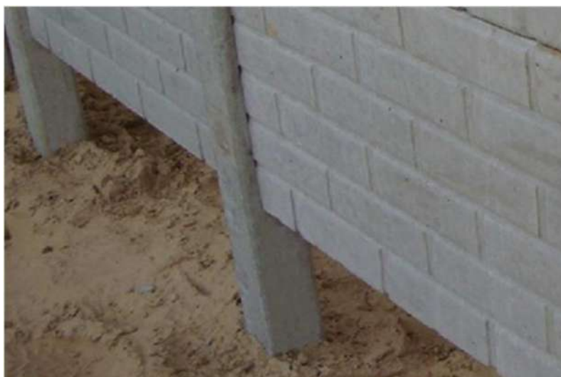
Figura 47 – Pilares prefabricados enterrados.
