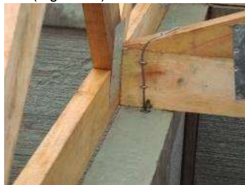
Figura 59 – Fijación del alambre de acero galvanizado a la cercha del sistema de cobertura.
