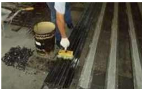
Figura 38 – Aplicación del desmoldante.
