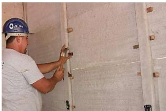
Figura 69 – Fijación temporal de las placas mediante cuñas de madera.
