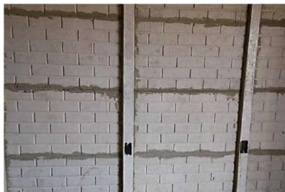
Figura 70 – Rejunte en argamasa AC III entre placas y pilares.
