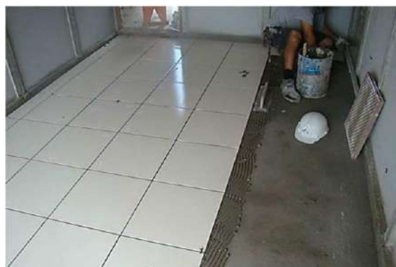
Figura 83 – Colocación del revestimiento cerámico.
