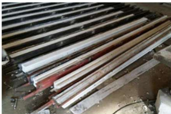
Figura 35 – Desencofrado de los pilares en hormigón armado.
