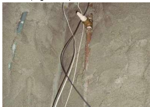
Figura 79 – Cañería hidráulica embutida en el revoque fino.
