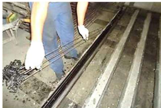
Figura 28 – Posicionamiento del armazón en el encofrado metálico.
