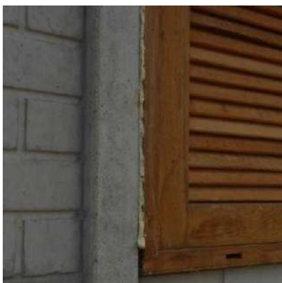
Figura 56 – Vano entre pilar y ventana relleno con espuma expansiva a base de poliuretano.
